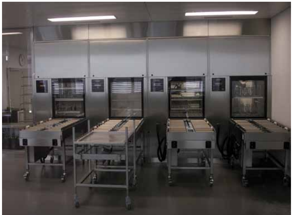
«Reine Seite» der Zentralsterilisation in Zug. Hier werden die gereinigten Instrumente in Sets verpackt und gehen weiter zur Sterilisation.
